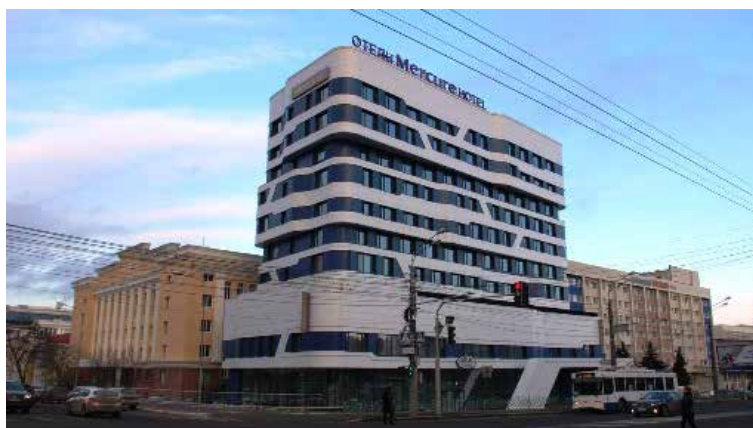
Рис. 1. Здание отеля «Mercure»
